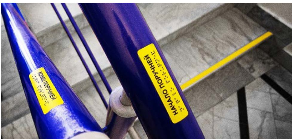
Рис. 1. Тактильные указатели направления перед подъемом по лестнице в медицинском консультативном центре (Вологодская область)
